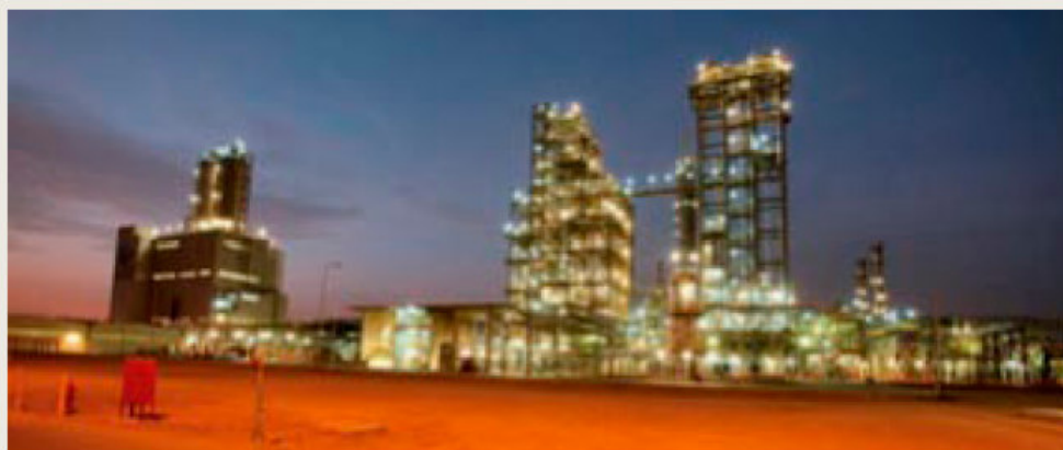
Impianto petrolchimico (Arabia Saudita)
